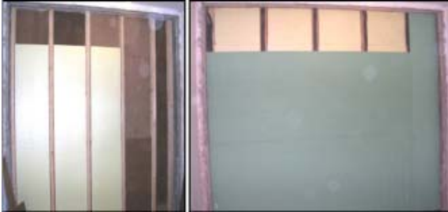
Figura 1 – Campione in prova lato sorgente: due fasi di posa del campione.
